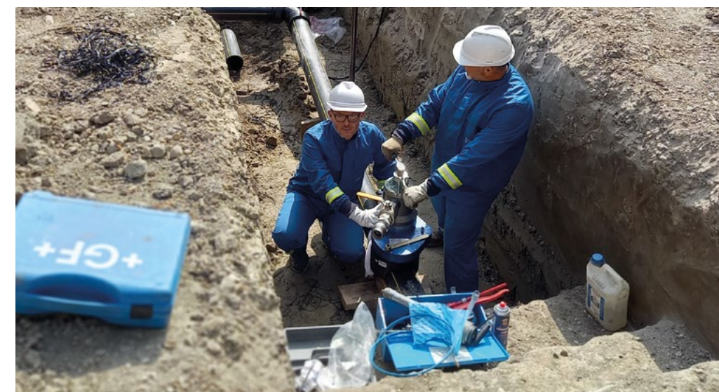
A MOSONMAGYARÓVÁRI ÖNKORMÁNYZAT ÁLTAL LÉTESÍTETT LAKÓPARK GÁZELLÁTÁSÁNAK ÜZEMBE HELYEZÉSE RAVETTI ESZKÖZ HASZNÁLATÁVAL Fotó: Sipos Ildikó
