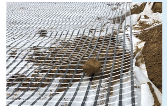
KÉT RÉTEG GEORÁCSOT ALAKÍTOTTUNK KI Fotó: Kovács János
