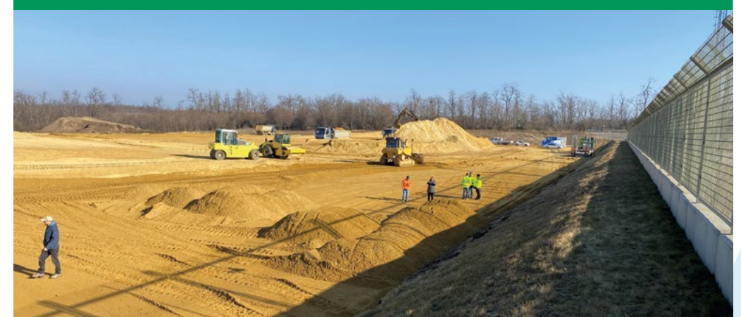
AZ 1B ÜTEM HAMAR UTOLÉRTE AZ 1A ÜTEMBEN ELKÉSZÜLT KORÁBBI TÖLTÉSMAGASSÁGOT Fotó: Kovács János
