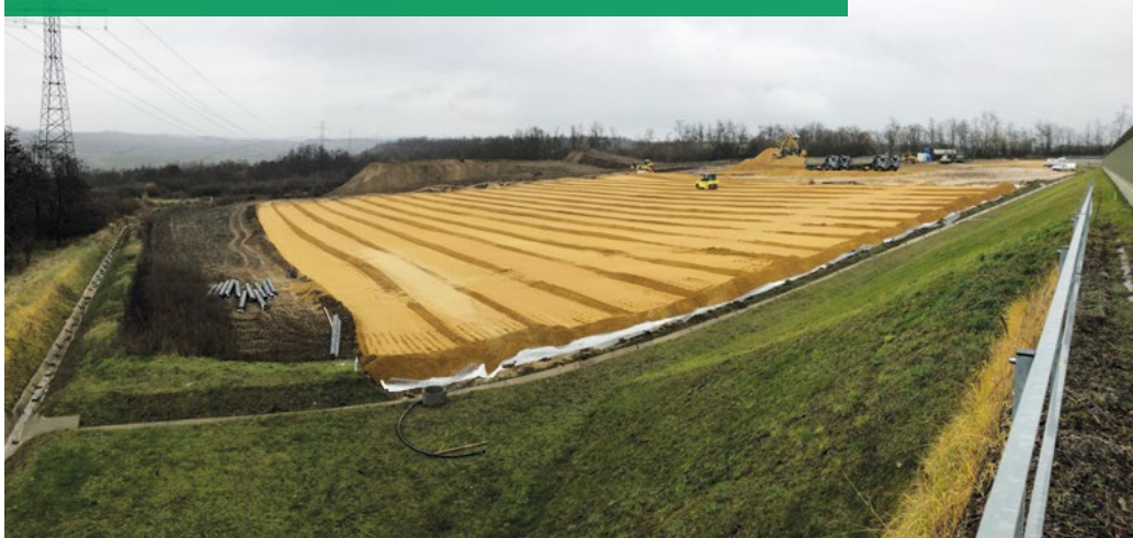
IGYEKEZTÜNK KÉT-HÁROM ESŐMENTES NAPON ELKÉSZÍTENI A BEVÁGÁST Fotó: Kovács János
