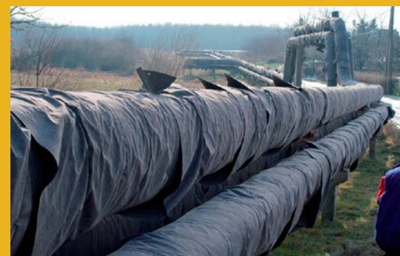
A RÉGI, FELSZÍN FELETT Vezetett csövek és az új, előszigetelt vezeték, amelyek a földbe kerültek (oroszlány)
