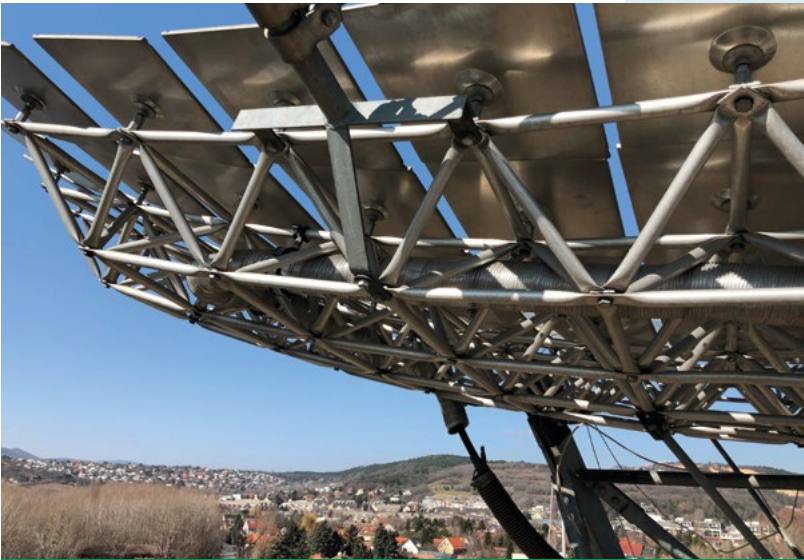
2. KÉP: A TÜKRÖK RÖGZÍTÉSE A RÁCSSZERKEZETBEN
